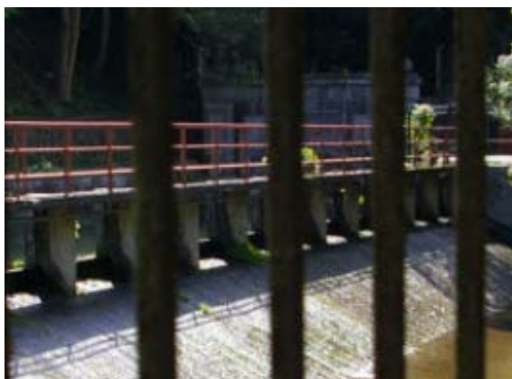
合流後のトンネル出口
