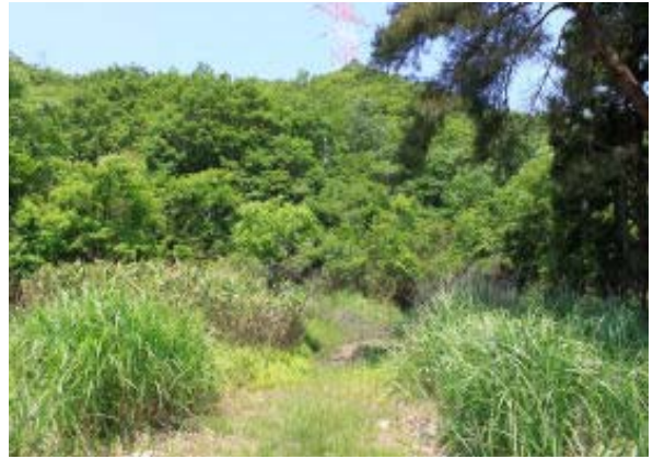
このあたりに下りてくる（奥35号鉄塔）
